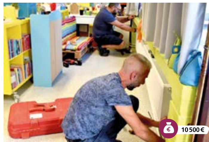
Au Roleur, les radiateurs ont été remplacés dans la partie primaire.
